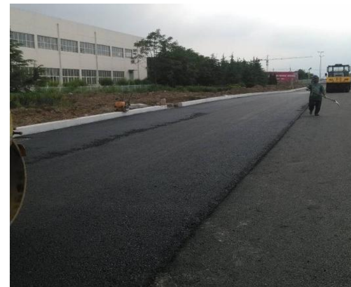
步骤七：新旧道路接缝处沥青面层施工
