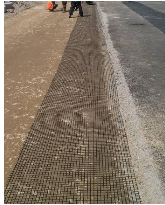
步骤三：新旧道路基层接缝处铺设土工格栅
