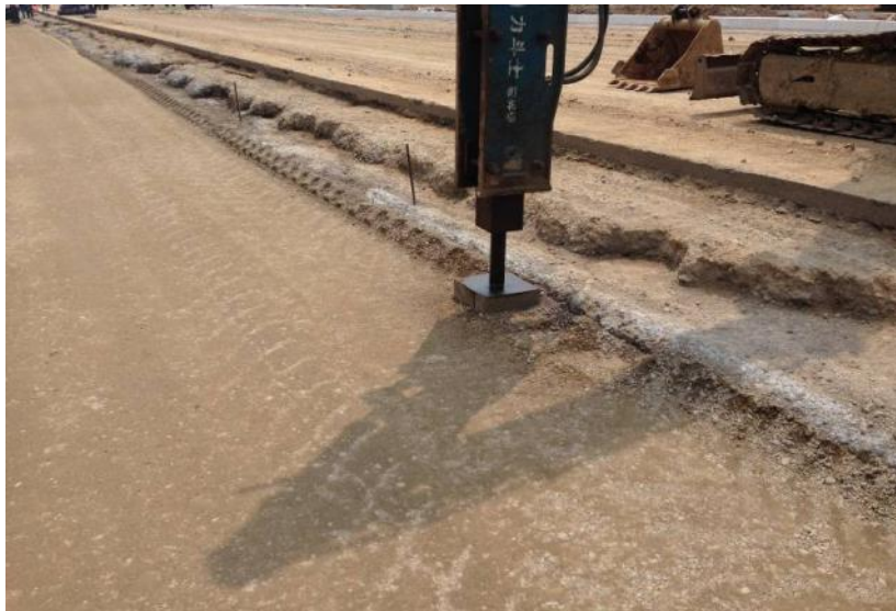
步骤一：专业机具对旧道路基层接缝夯实
