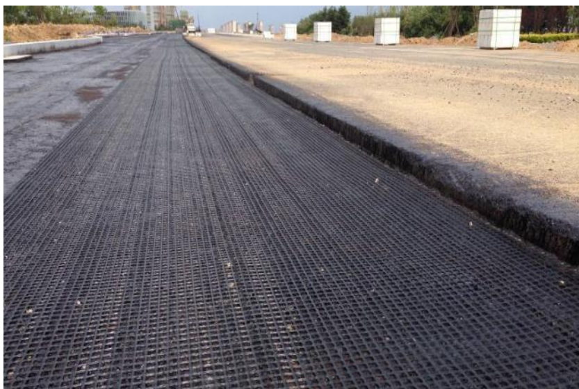
步骤五：新旧道路沥青面层接缝处铺设土工格栅
