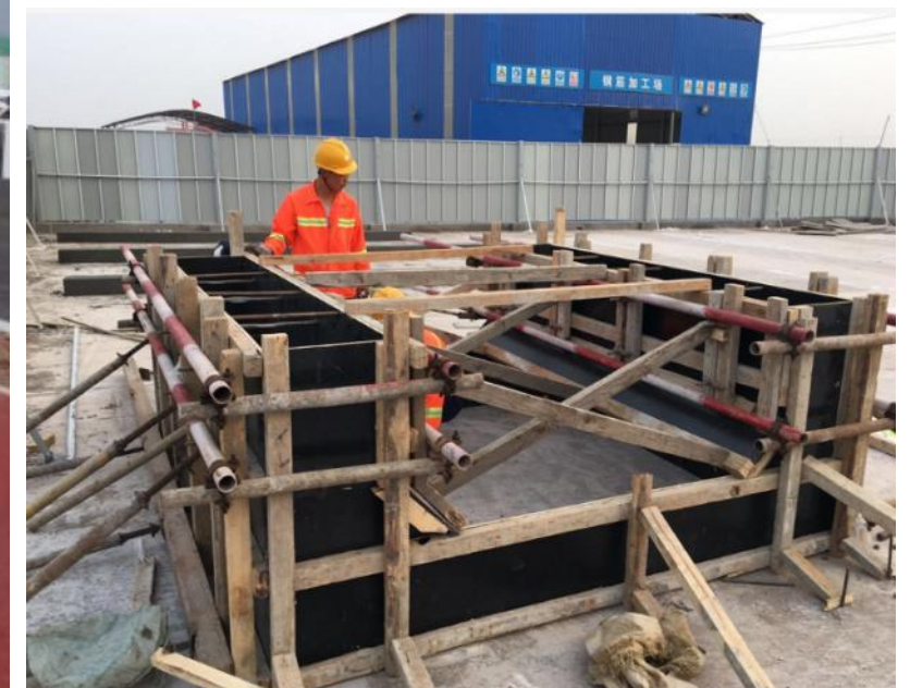
钢筋砼实体样板块
