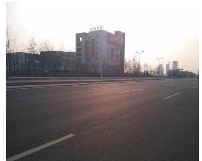
步骤八：新旧道路沥青接缝施工完成
