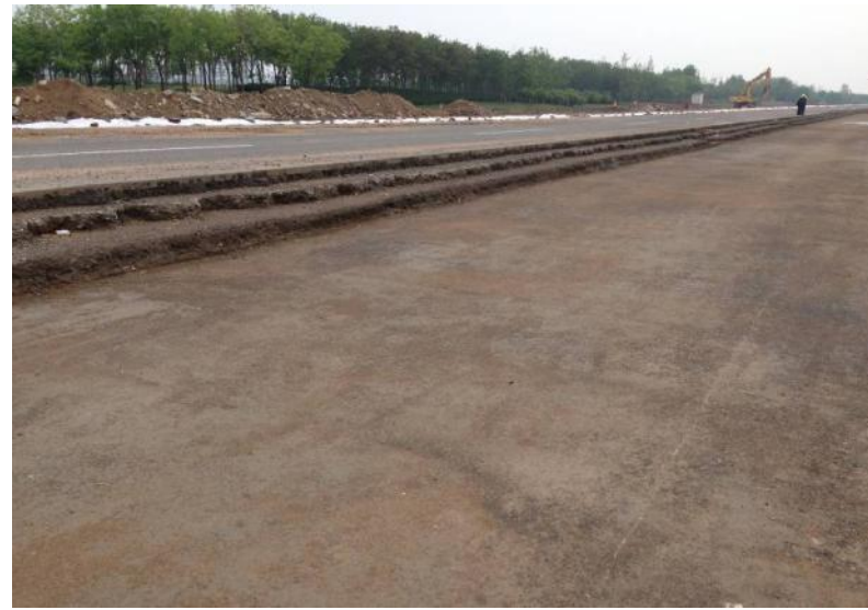
步骤二：新旧道路基层接缝全线夯实完成
