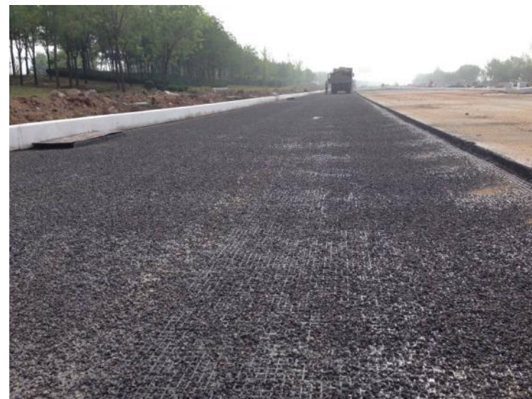
步骤六：土工格栅处洒布封层并碾压，增大沥青层间及接缝处粘结度
